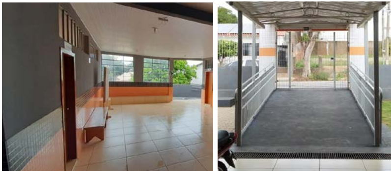
Figura 15: Pisos sem sinalização tátil. Fonte: Fotos registradas pelo autor (2022)
