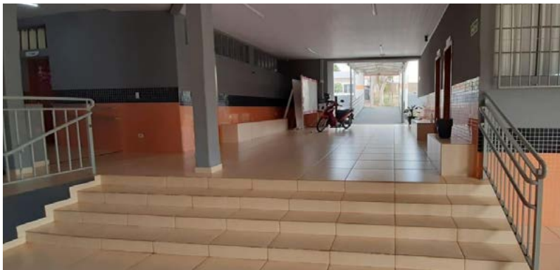
Figura 18: Escada de ligação entre banheiros e pavilhão 1. Fonte: Fotos registradas pelo autor (2022)
