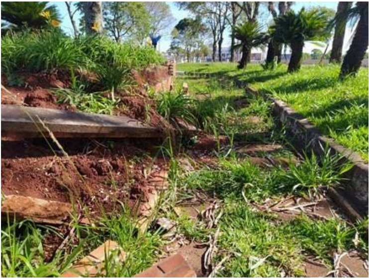
Figura 11 – Conservação e limpeza. Fonte: O Autor, 2022
