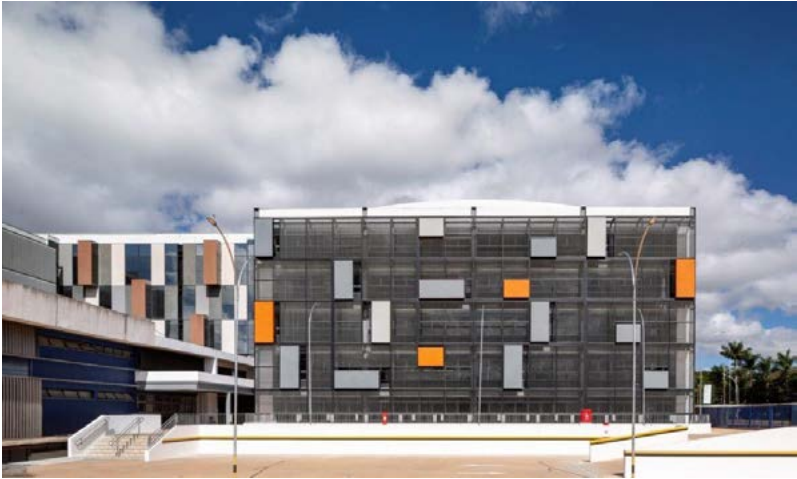
Figura 8 – Brise metálico utilizado na Fachada do Centro Universitário UDF, Brasília - Brasil. Fonte: Radar decoração, 2020.
