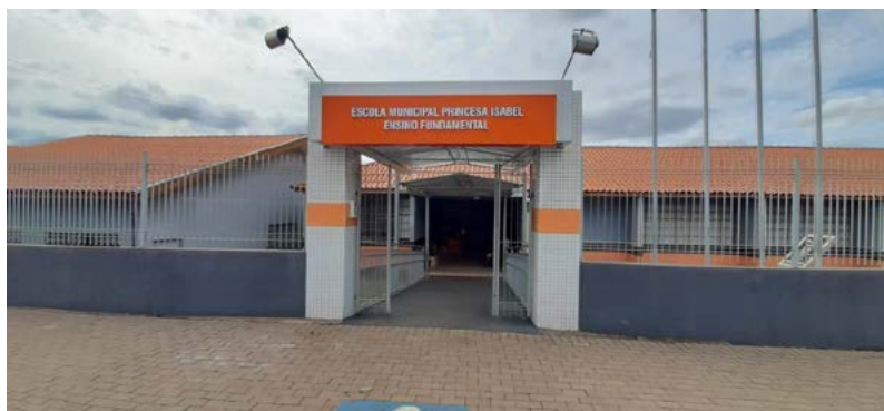
Figura 14: Fachada da escola foco do estudo. Fonte: Fotos registradas pelo autor (2022)
