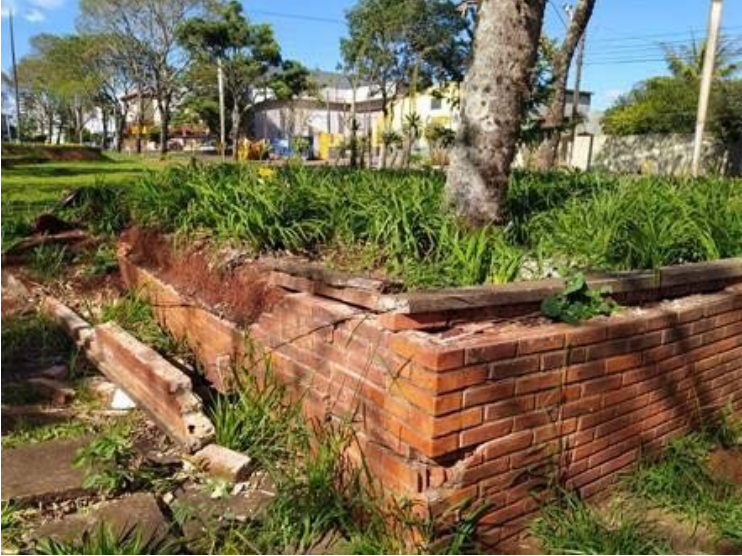
Figura 10 – Conservação e limpeza. Fonte: O Autor, 2022
