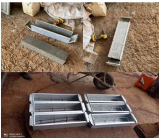
**Figura 3.** Desmoldando / armaduras prontas para concretagem
