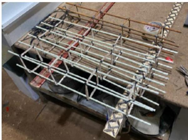
**Figura 14.** Preparo das armaduras de GFRP, uso de abraçadeira Nylon para fixação dos Estribos.
