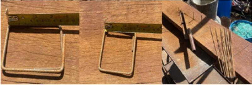
**Figura 10.** Execução dos Estribos em aço.
