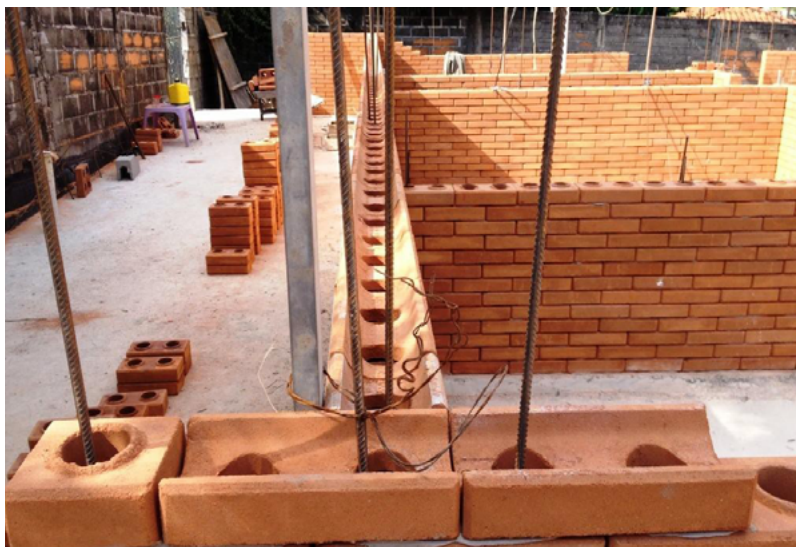
Figura 27. Obra em execução feita com tijolo ecológico.
