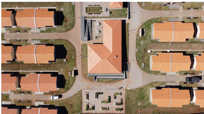
Figura 2. Imagem aérea da implantação do condomínio do idoso de Foz do Iguaçu, PR, com foco no núcleo central.
